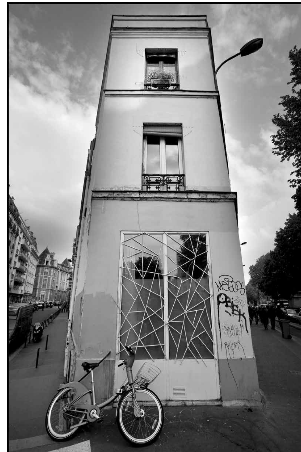
Corner Quai Jemmapes, Rue Bichat, 19e Arrt, Paris, France - 2010
