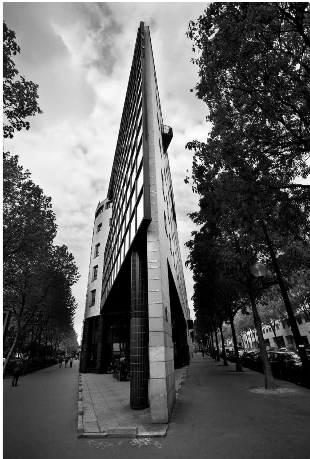
Corner Rue Armand Carral, Avenue Jean Jaures, 19e Arrt, Paris, France - 2010
